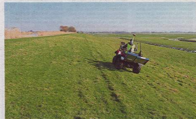
Dijksinspectie met de quad.
